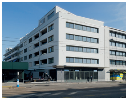
Zürich Badenerstr. 696, J. Fügli-Strasse 16, 18, Bachmattstrasse 53
