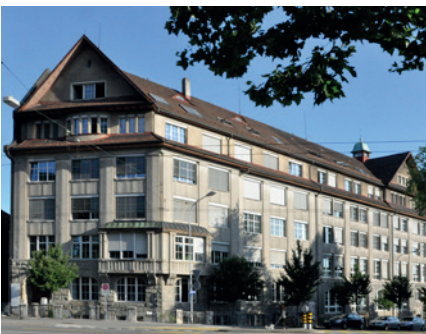
St. Gallen Rorschacherstr. 139, Helvetiastrasse 27
