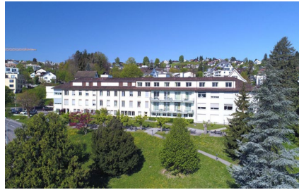
Richterswil Bergstrasse 16, Bodenstrasse 1, Boden- strasse 10
